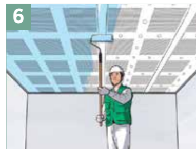
6 이음매 부위 컴파운드 도포 건조 후 페인트 도포를 하여 시공을 마무리합니다.
