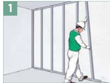
1 상하부 러너 및 스테드 시공
