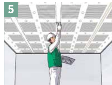
5 이음매 부위에 조인트 컴파운드를 도포합니다. *USG Boral의 시트락 조인트 컴파운드를 사용하시면 더욱 깔끔한 일메이움이 가능합니다.
