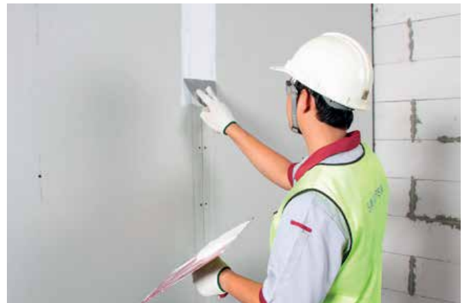
5 ฉาบรอยต่อแผ่นยิปซัม ตามมาตรฐานยิปซัม ตราช้าง - ฉาบ 3 ชั้นตอน - ทุกแนวรอยต่อต้องใส่ผ้าเทปหรือคิ้วตกแต่งมุมยิปซัม - การขัดแนวรอยฉาบ ต้องทิ้งให้แนวรอยฉาบแห้งสนิท 24 ชั่วโมง จากนั้นจึงทาสีหรือตกแต่งตามต้องการ
