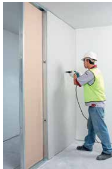
4 ตัดตั้งแผ่นยิปซัมขอบลาด ความหนา 12 มม. ขึ้นไป ยึดเข้ากับโครงคร่าวด้วยสกรูยึดแผ่นยิปซัม ระยะห่างไม่เกิน 300 มม. ที่กลางแผ่น ระยะห่างไม่เกิน 200 มม. ที่ขอบแผ่น และสกรูห่างจากขอบแผ่นไม่น้อยกว่า 10 มม. ตัดตั้งแผ่นยิปซัมเข้ากับโครงผนังทั้งสองด้าน การตัดตั้งแผ่นยิปซัมบริเวณช่องเปิด ขอบวงกบประตูให้ใช้วิธีบากแผ่นคร่อมแนวช่อง
