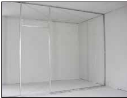
1. ฟูพลาสติก ติดตั้งโครงคร่าวผนังโซลิด ด้วย 50 มม.
